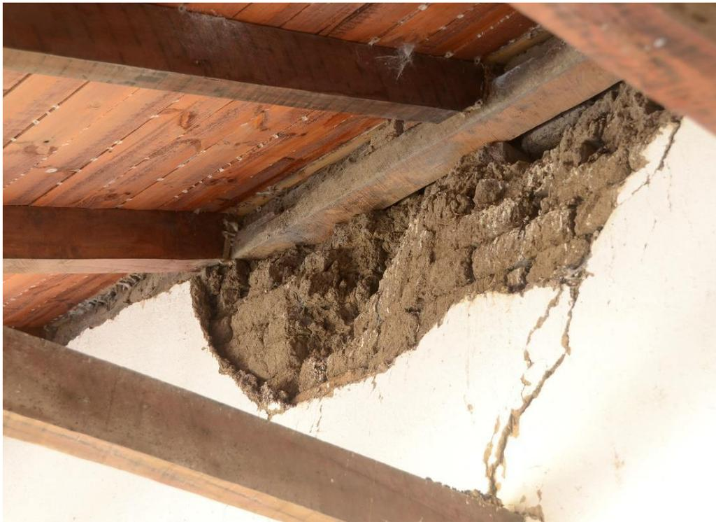
DETERIORO DE MUROS DE ADOBE POR HUMEDAD Y TENSIONES GENERADAS DURANTE SISMOS
