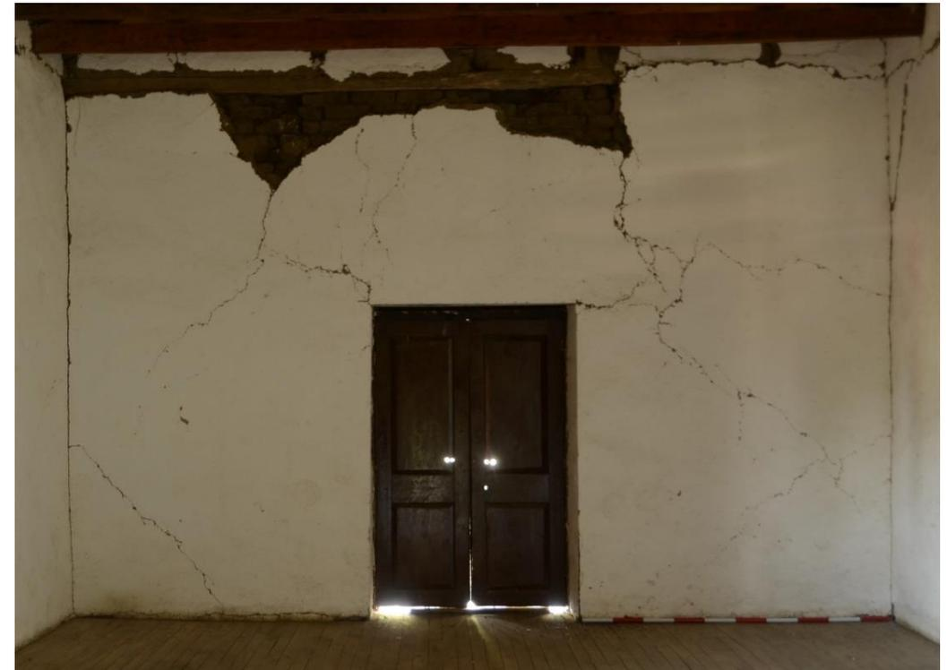
GRIETAS CAUSADAS POR LA TENSIÓN GENERADA ENTRE LOS DISTINTOS MATERIALES DURANTE EL SISMO.
