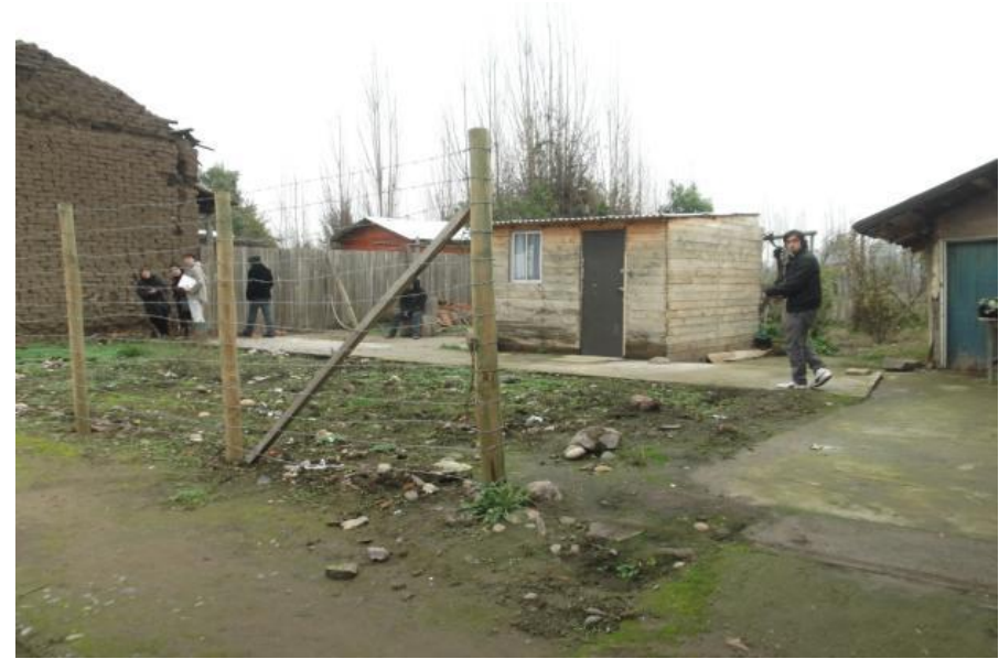
IMAGEN DEL SITIO DESPUÉS DE TERREMOTO
