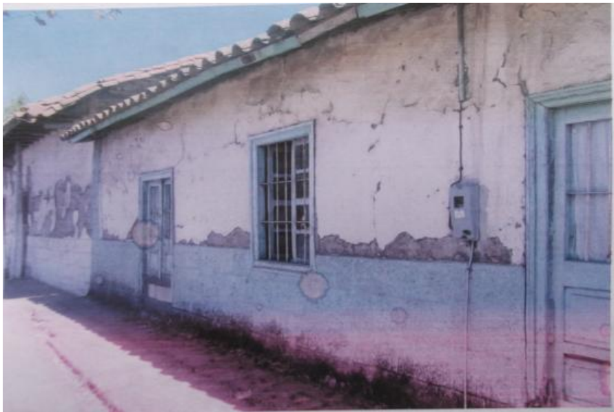
IMAGEN DE LA VIVIENDA ANTES DEL TERREMOTO
